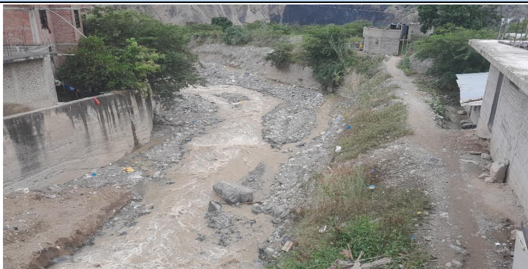
IMAGEN N°01: Se observa la quebrada del tingo requiere de mantenimiento de cauce
