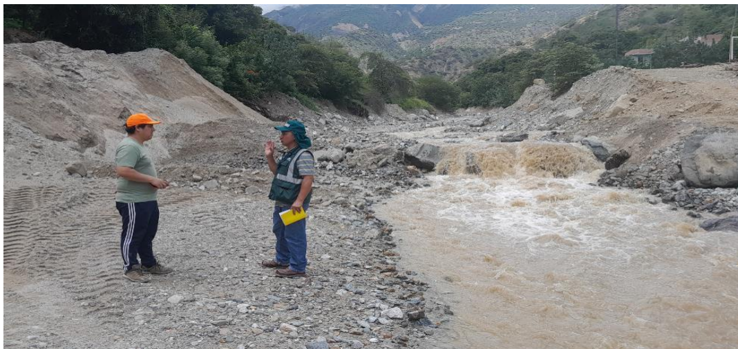
IMAGEN N°02: la quebrada el Tingo encuentra colmatada se extrae material de acarreo del cauce y requiere de conformacion de bordos
